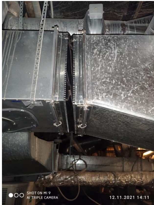
Фото 27 и 28 – Вид недопустимого монтажа вентиляционной установки В27 - гибкие вставки одна в растянутом состоянии, другая сжато
