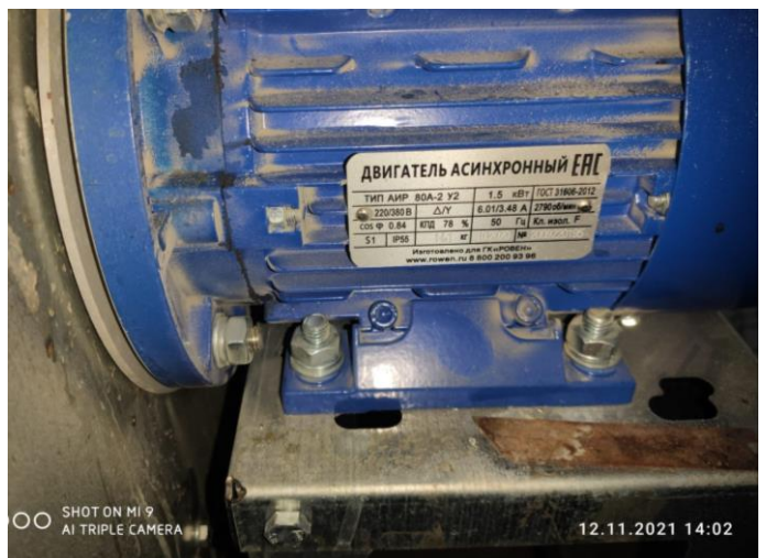
Фото 17 и 18 - Смонтированная вентиляционная установка В25.2 имеет непроектные характеристики (не соответствует проекту)
