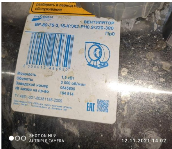
Фото 17 и 18 - Смонтированная вентиляционная установка В25.2 имеет непроектные характеристики (не соответствует проекту)
