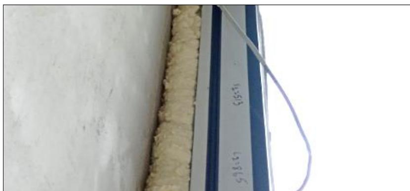
Фото 30 – Отсутствие внутреннего слоя герметизации монтажного шва окна ОК-1.1
