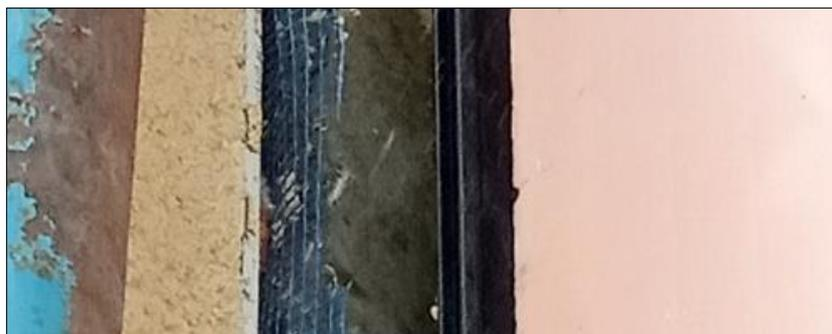
Фото 37 – Отсутствие наружного слоя герметизации монтажного шва окна В-1
