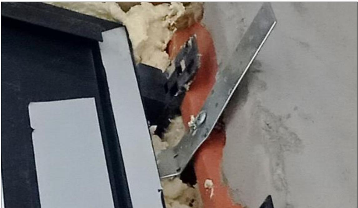
Фото 21 - Узел крепления окна ОК-2.3 к стенам проема с использованием соединительной пластины
