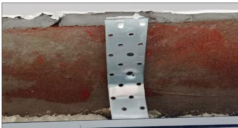
Фото 6 – Отсутствие крепления соединительной пластины к проему.
