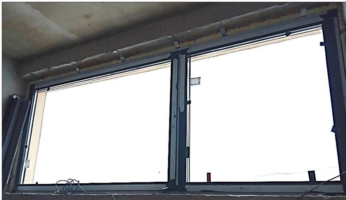
Фото 16 - отсутствует внутренний слой герметизации монтажного окна ОК-2.2
