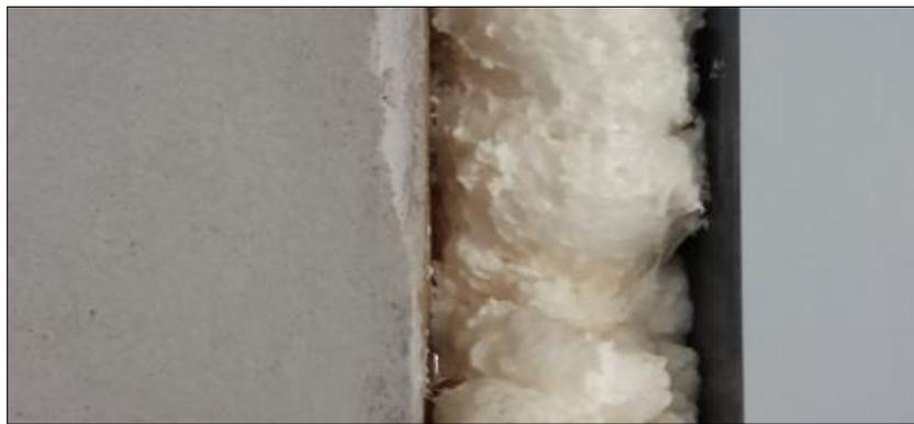
Фото 36 – Отсутствие внутреннего слоя герметизации монтажного шва окна В-1
