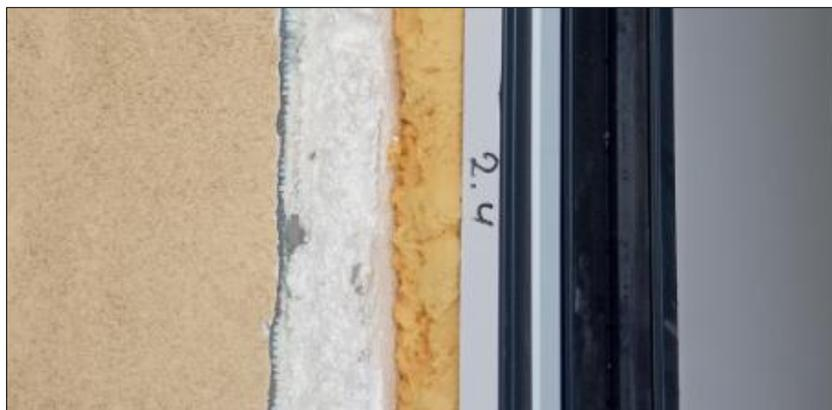
Фото 26 – Отсутствие наружного слоя герметизации монтажного шва окна ОК-2.4
