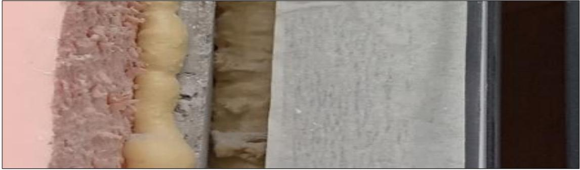
Фото 40 - Отсутствие наружного слоя герметизации монтажного шва окна ОК-3.1
