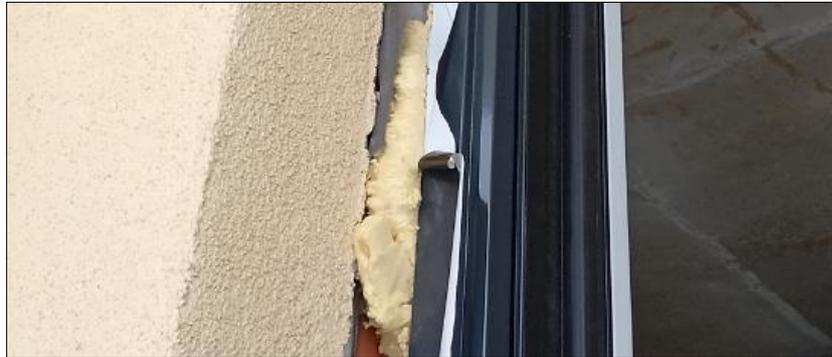
Фото 23 – Отсутствие наружного слоя герметизации монтажного шва окна ОК-2.3
