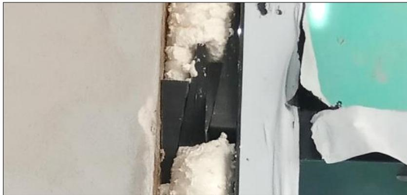
Фото 34 - Положение установочных клиньев в утеплительном слое окна В-1
