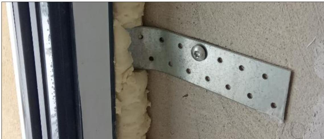
Фото 24 - Узел крепления окна ОК-2.4 к стенам проема с использованием соединительной пластины
