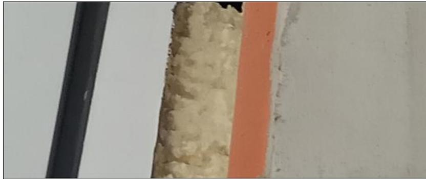
Фото 22 – Отсутствие внутреннего слоя герметизации монтажного шва окна ОК-2.3
