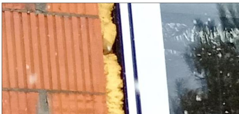
Фото 31 – Отсутствие наружного слоя герметизации монтажного шва окна ОК-1.1
