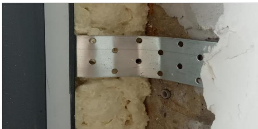
Фото 4 – Узел крепления окна ОК-2.7 к стенам проема с использованием соединительной пластины
