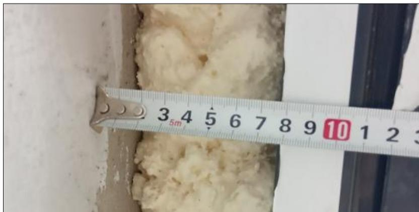
Фото 28 - Ширина монтажного зазора окна ОК-1.1
