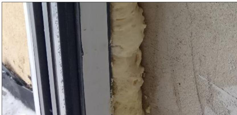
Фото 25 – Отсутствие внутреннего слоя герметизации монтажного шва окна ОК-2.4
