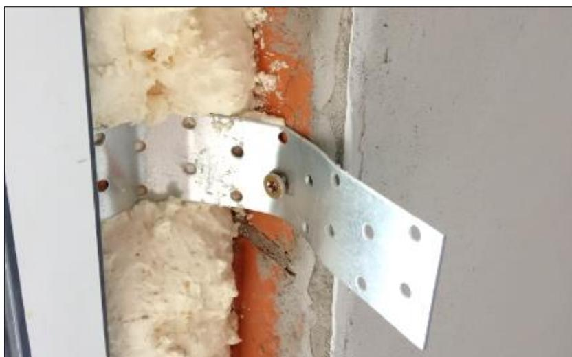
Фото 29 - Узел крепления окна ОК-1.1 к стенам проема с использованием соединительной пластины
