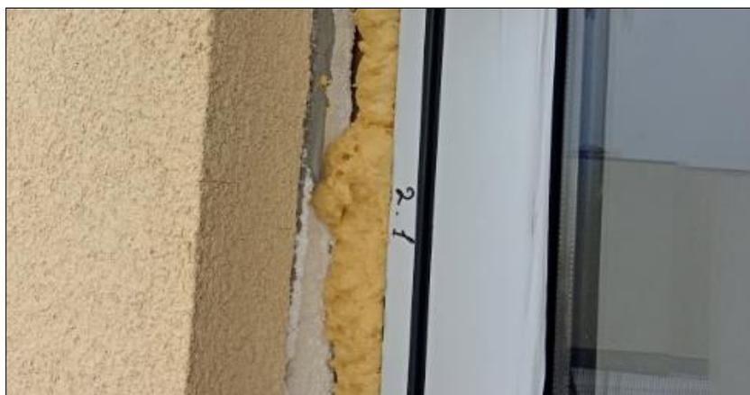
Фото 13 – Отсутствие наружного слоя герметизации монтажного шва окна ОК-2.1
