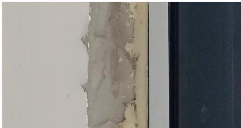
Фото 12 – Отсутствие внутреннего слоя герметизации монтажного шва окна ОК-2.1
