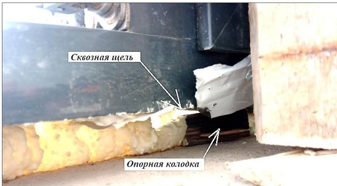
Фото 1 – вид на опорную колодку и сквозную щель окна ОК-2.7
