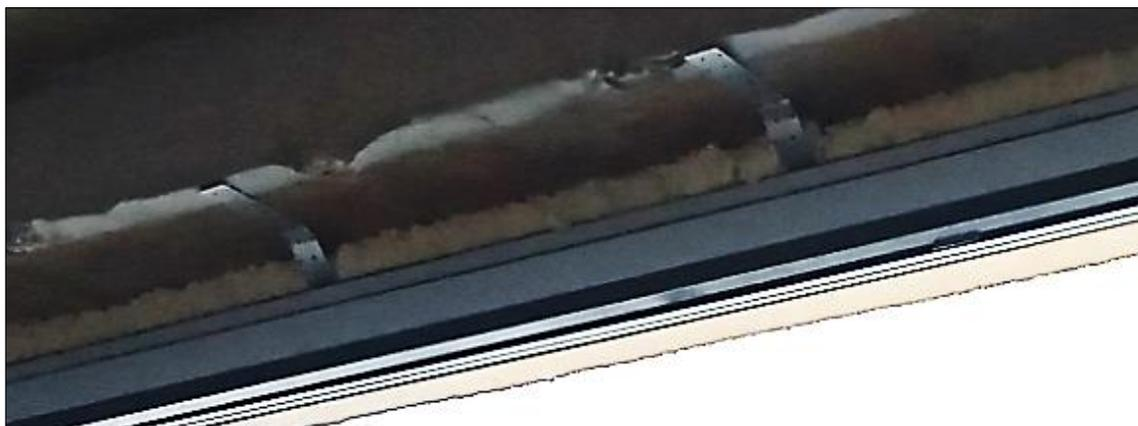
Фото 17 – Крепление окна ОК-2.2 к стенам проема с использованием соединительных пластин
