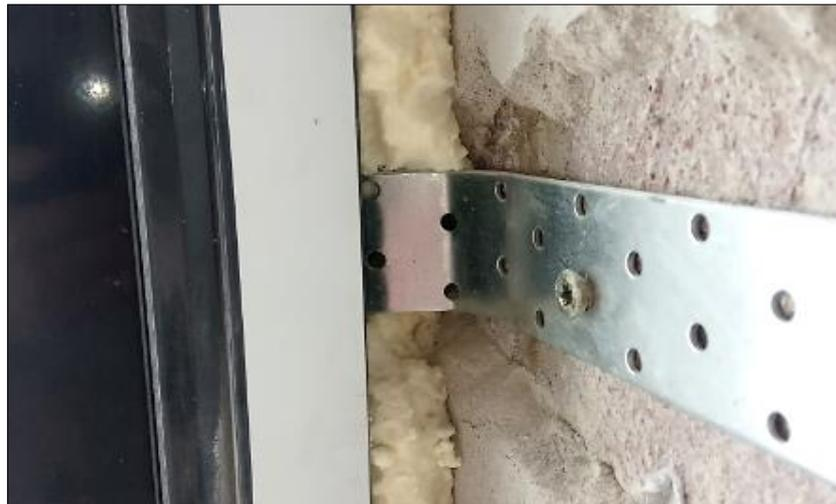
Фото 14 - Узел крепления окна ОК-2.1 к стенам проема с использованием соединительной пластины
